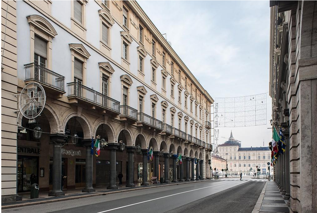
Fig. 11. Via Roma-ultimo isolato
